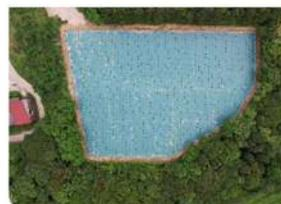
新日本電工(株)妙高工場 残渣処分場D地区遮水シート設置 >
