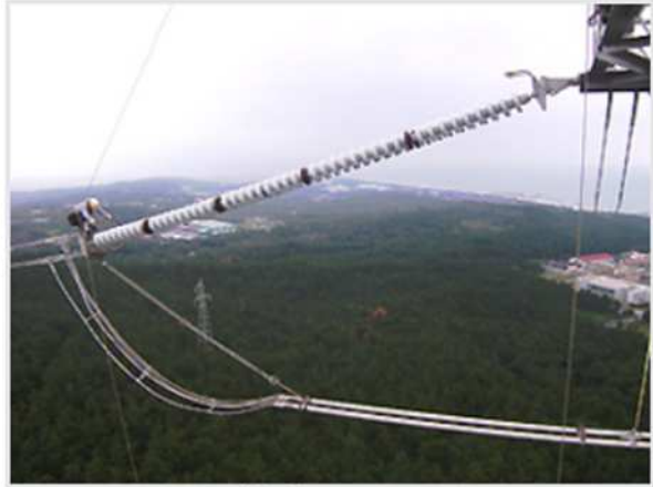
送電線がいし点検作業
