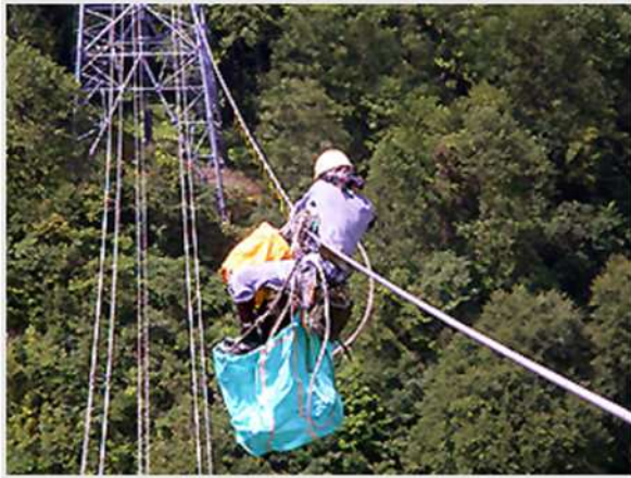
送電線点検作業
