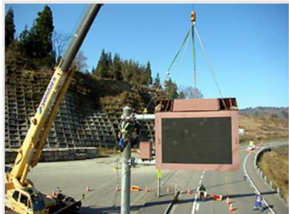
道路表示板取付作業
