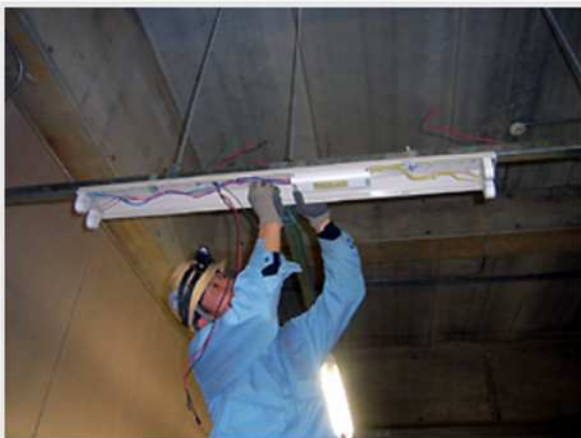
蛍光灯取付作業
