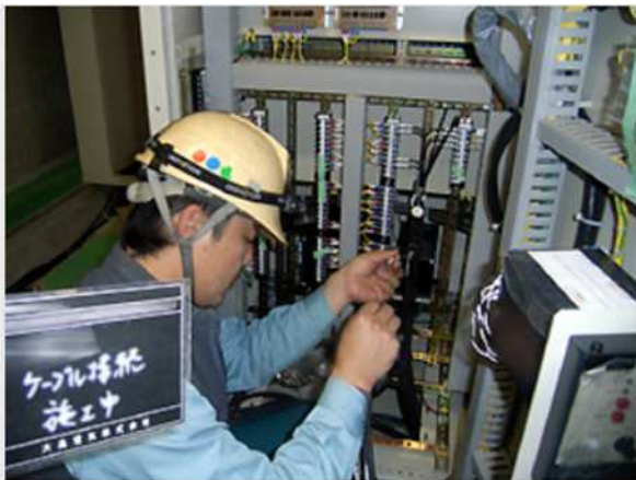
ケーブル接続作業
