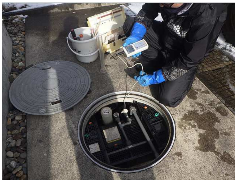
【浄化槽の点検作業の様子】
